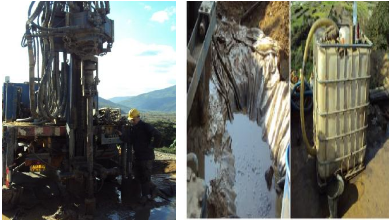
Figure n°4.III : matériel du sondage carotté.
