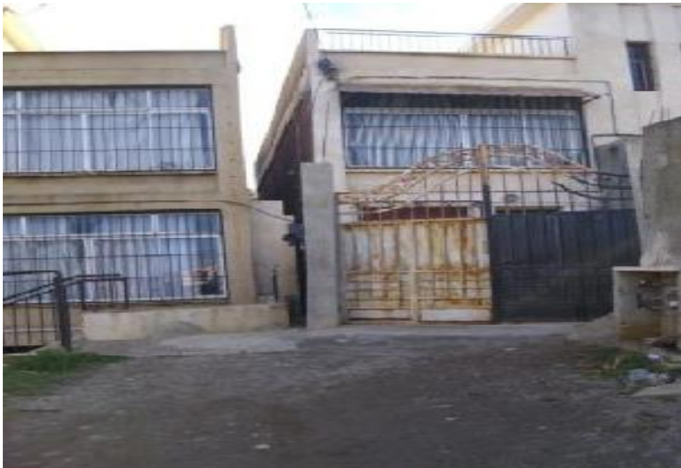
Figure n°10.II : Ouverture d'un joint entre deux blocs.
