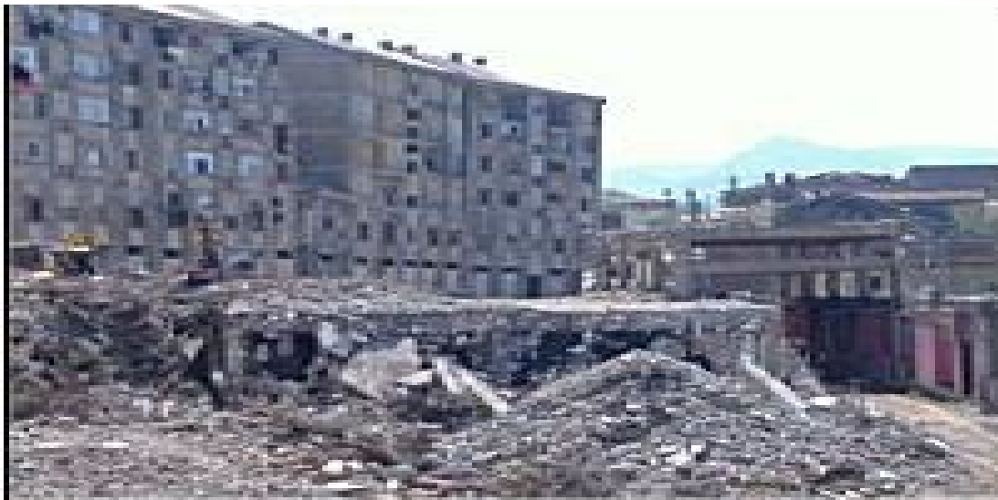
Figure n°5.II : Démolitions des bâtiments.
