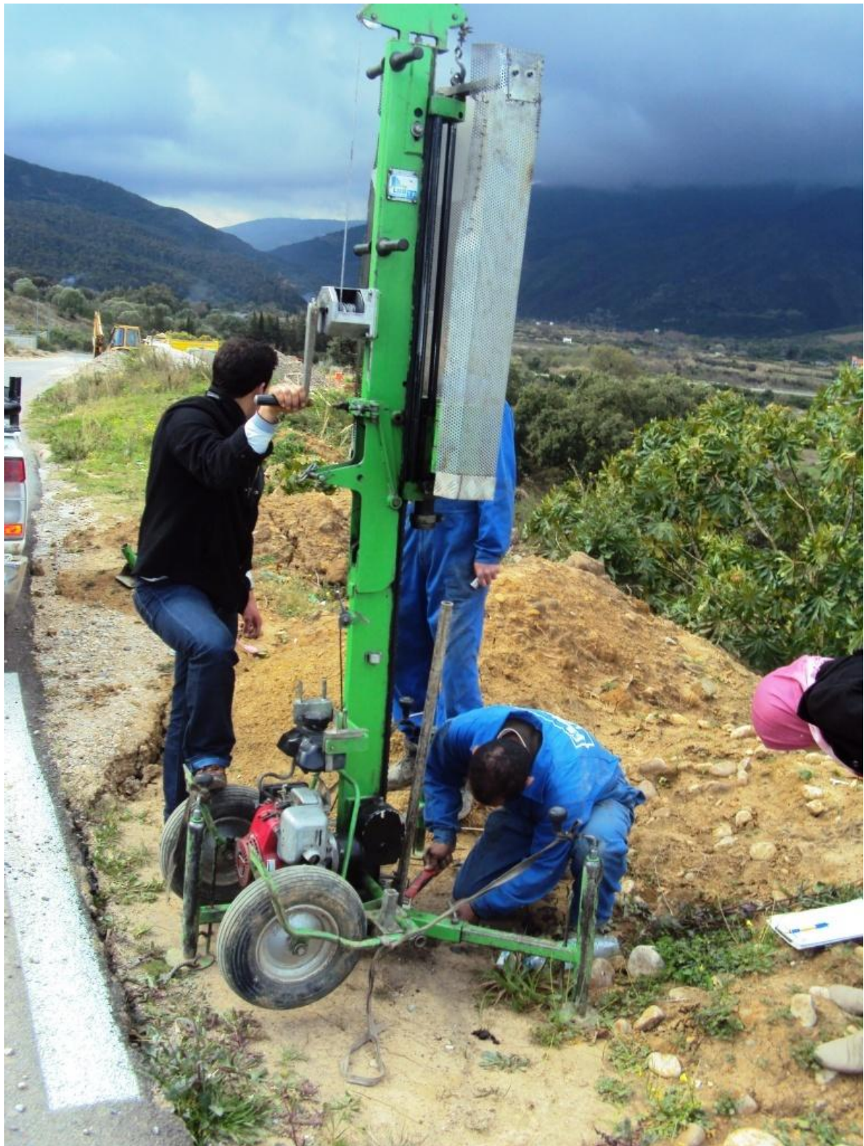
Figure n°1. III : Photo d'un pénétromètre dynamique.
