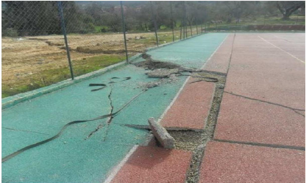
Figure n°2.II : Affaissement d'un stade.
