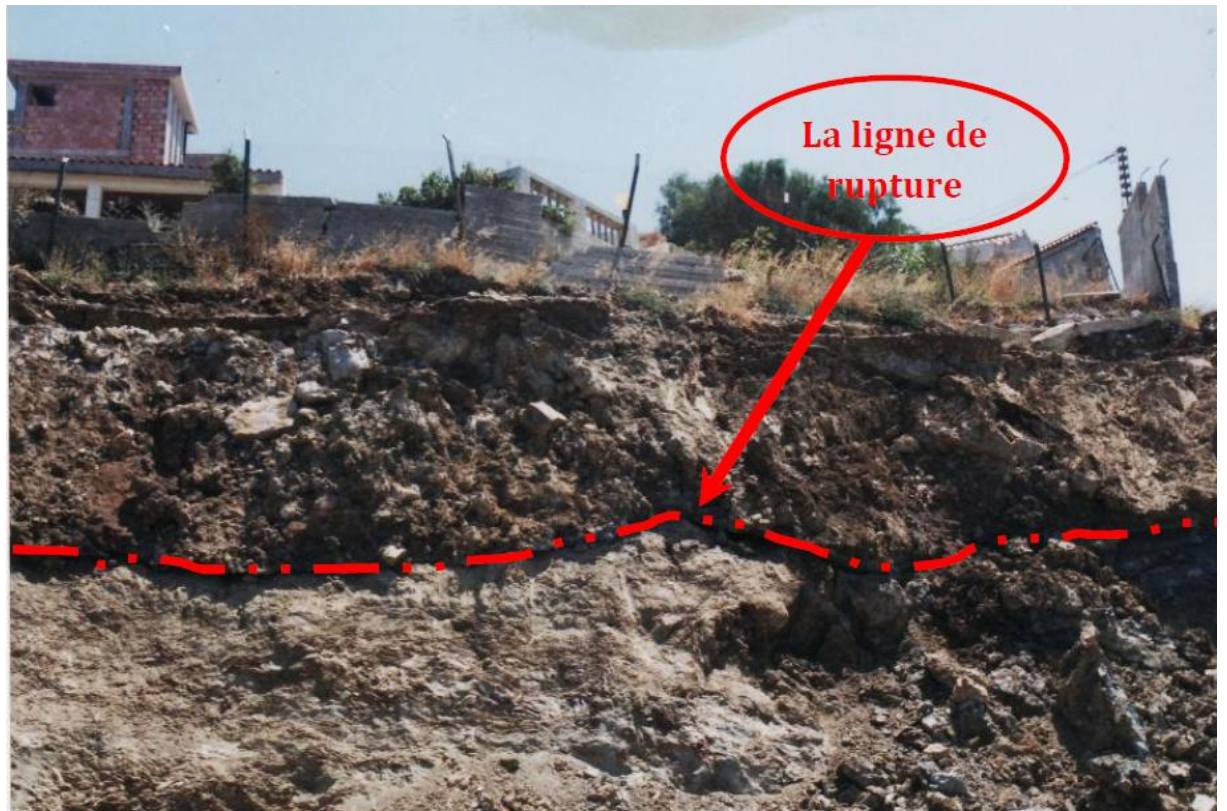
Figure n°9.II : Glissement d'un talus.
