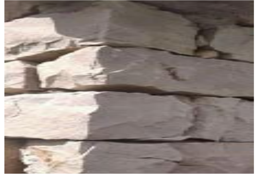
Figure 12: système de pose d'une maison à voumansour.
