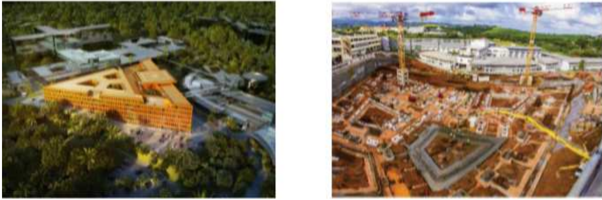
Figure I.6 : Hôpital Pierre Zobda-Quitman sur appuis parasismique [12][13].
