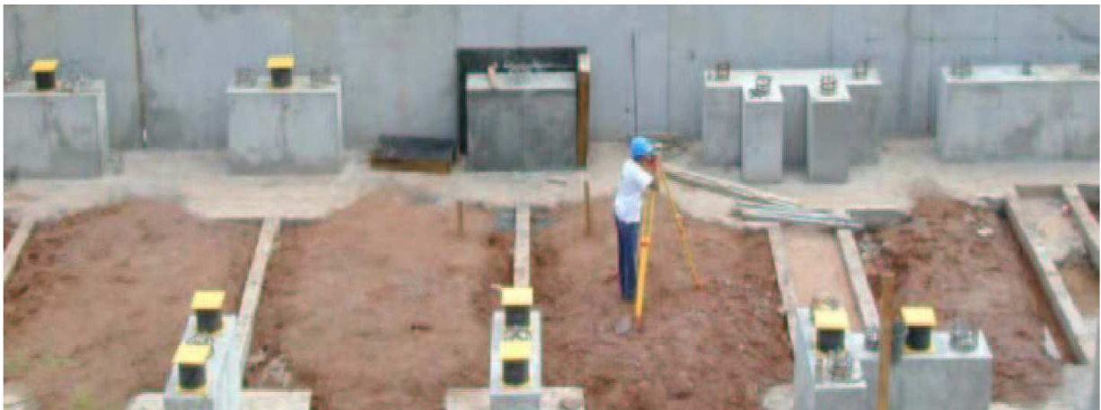
Figure I.1 : implantation des appuis parasismiques [17].
