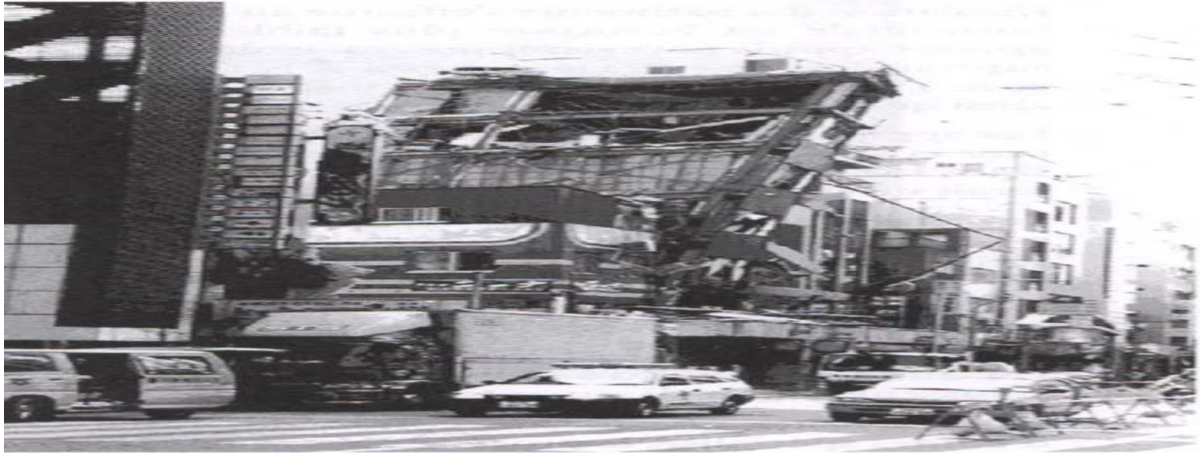
Figure I.9.a : Dommages dus à des oscillations importantes de la structure (Séisme de Kobe, Japon ; 17 janvier 1995) [6]
