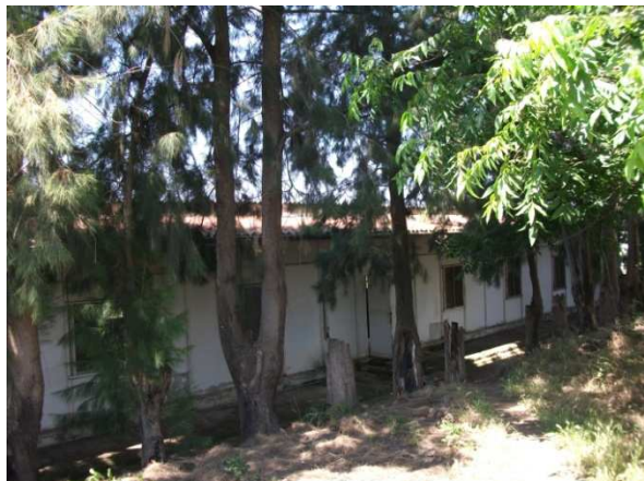
b : Façade nord-ouest du bâtiment
