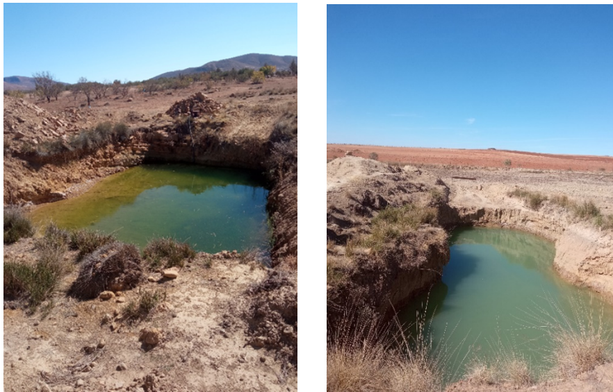
Figure 25 : photos montrant deux lacs d'eaux au niveau de la digue.
