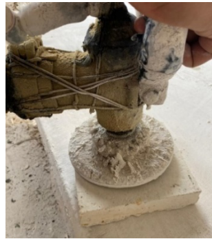
Figure 45 : ponçage des carreaux.
