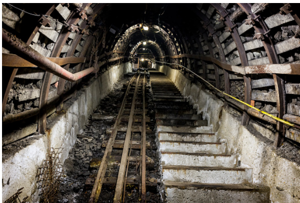
a : soutènement artificiel.
