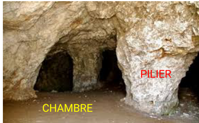
Figure 15 : Photo d'une chambre et d'un pilier abandonné (Google).
