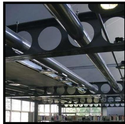
Figure 71: Les poutres alvéolaires
