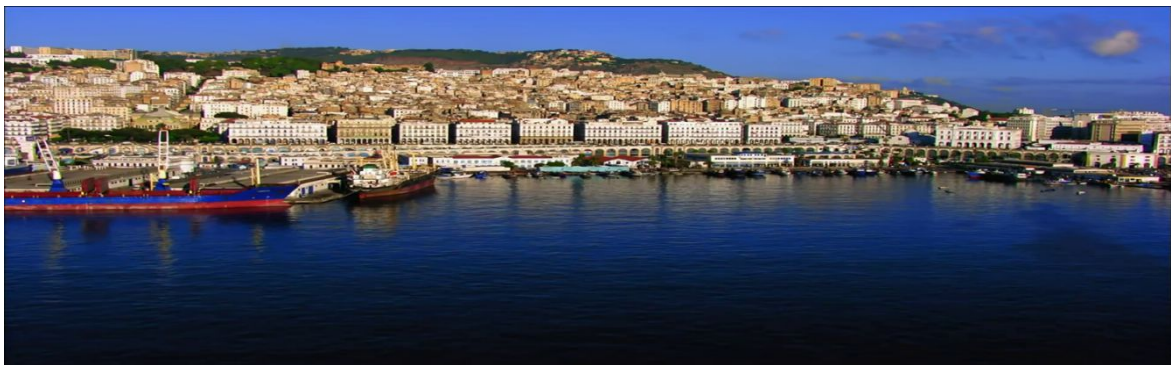
Fig.35: La façade maritime Source: www.algerie.vue.du.ciel.lbjnlkj.com
