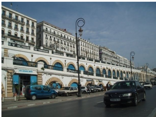
Fig.42: L'accès au quartier depuis bab l bhar Source: Auteur
