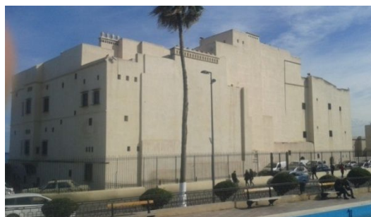
Fig.103: Réhabilitation du Bastion 23 Source: Auteur
