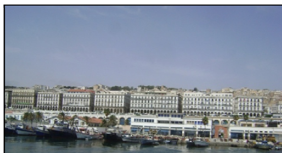
Fig.53: La façade maritime Source: Auteur
