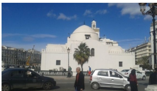
Fig.100: Réhabilitation du Djamaa El Djedid Source: Auteur
