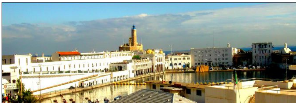
Fig.78: Construction en moyen état ( l'Amirauté) Source: Auteur
