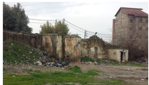
Fig.85 : Façade du troisième bâtiment Source : prise par l'auteur
