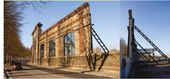
Fig.96 :Etaieement interne d'une façade historique des usines Renault a Boulogne Billancourt Source : manuel de réhabilitation
