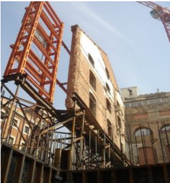
Fig.58: Photo de chantier : Soulèvement de la base source : Archilovers.com
