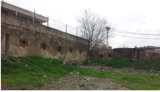
Fig.89 : Fenêtre en meurtrière vue de l'intérieure source : prise par l'auteur
