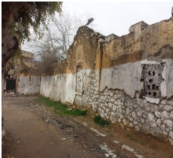
Fig.121 : Façade principale source : prise par l'auteur
