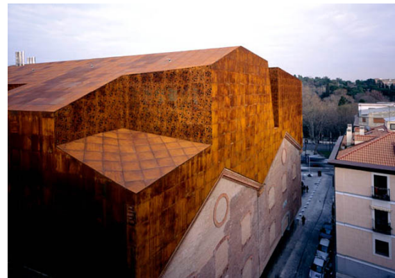
Fig.55: Vue sur le volume du Caixa forum, Madrid
