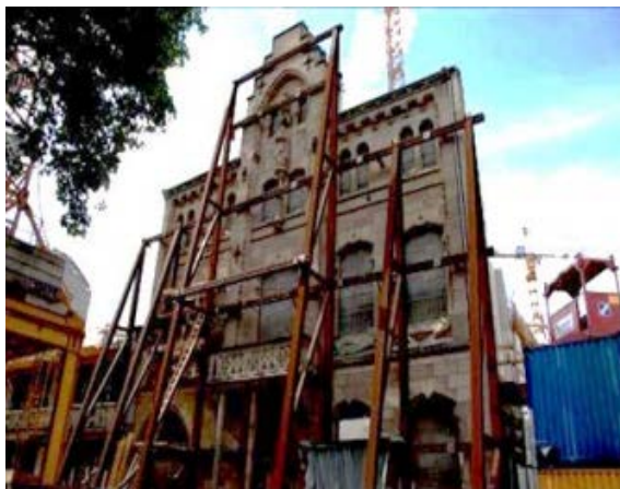
Fig.95 : étaieement de façade dors de réalisation de terrassement périphérique source : archivesouvertes.fr
