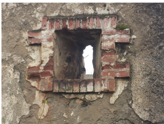
Fig.102 : Fenêtre en meurtrière dans la muraille source : prise par l'auteur
