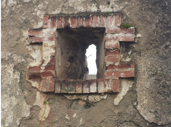
Fig.90 : Photo détaillé de la fenêtre. Source : Prise par l'auteur
