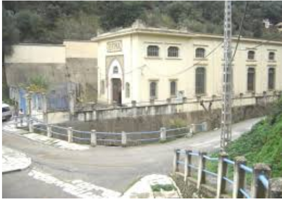
Fig.29 Bâtiment principale de la centrale hydro-électrique.
