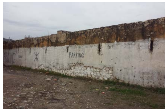
Fig.88 : Fenêtre en meurtrière vue de l'extérieur source : prise par l'auteur
