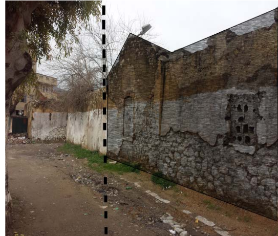
Fig.122 : Façade principale source : prise par l'auteur
