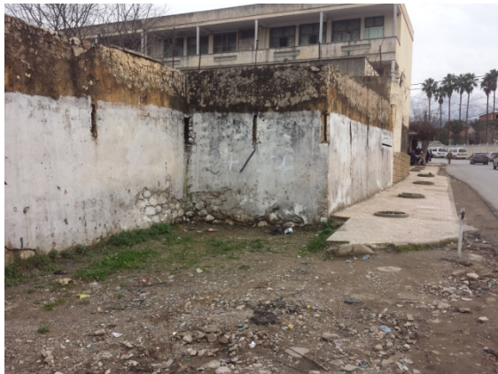
Fig.86 : Image montrant le batillons de la muraille source : photo prise par l'auteur
