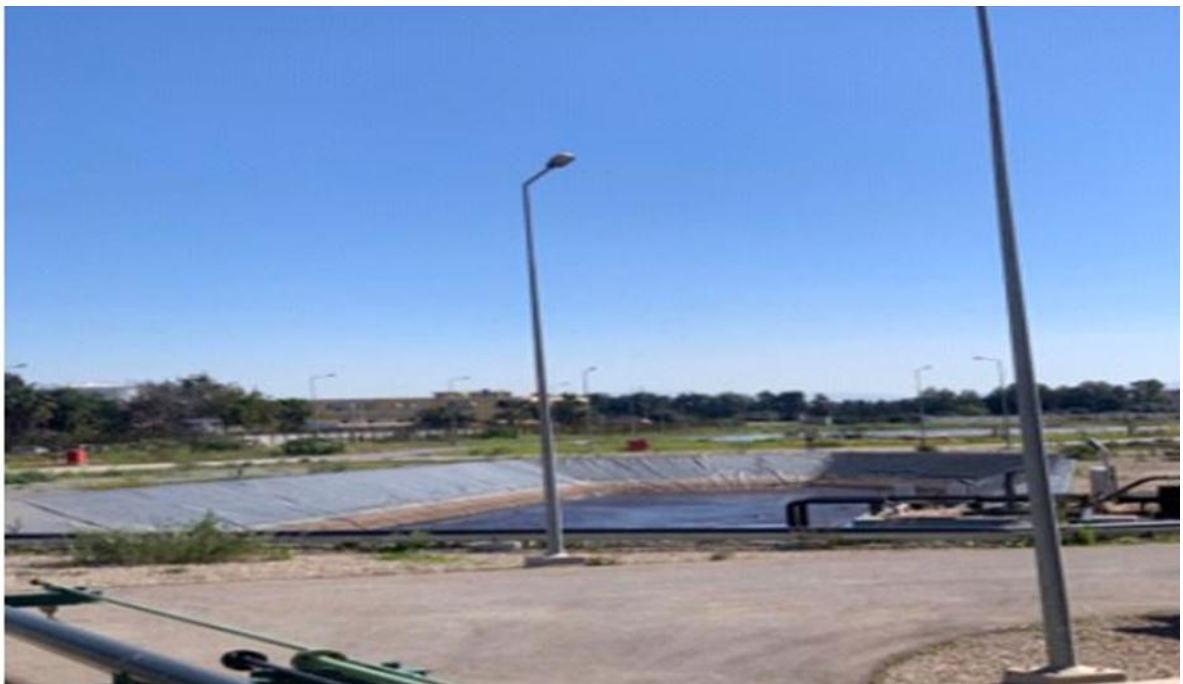
BASSIN D'ORAGE 850-CC017
