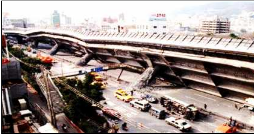
Figure 1.1. Tremblement de terre de Kobe. Janvier 1995.
