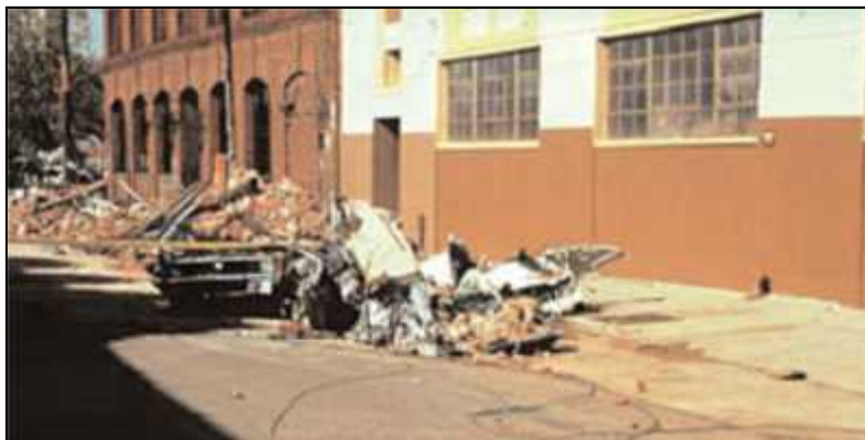
Figure 2.16. La chute de briques de parement lors du séisme de Loma Prieta, Californie, 1989.
