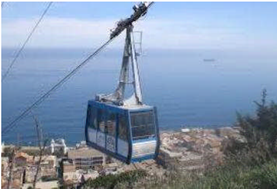
Figure 1-4 : Vue d'une télécabine entre Oued Koriche et Bouzaréah, Alger
