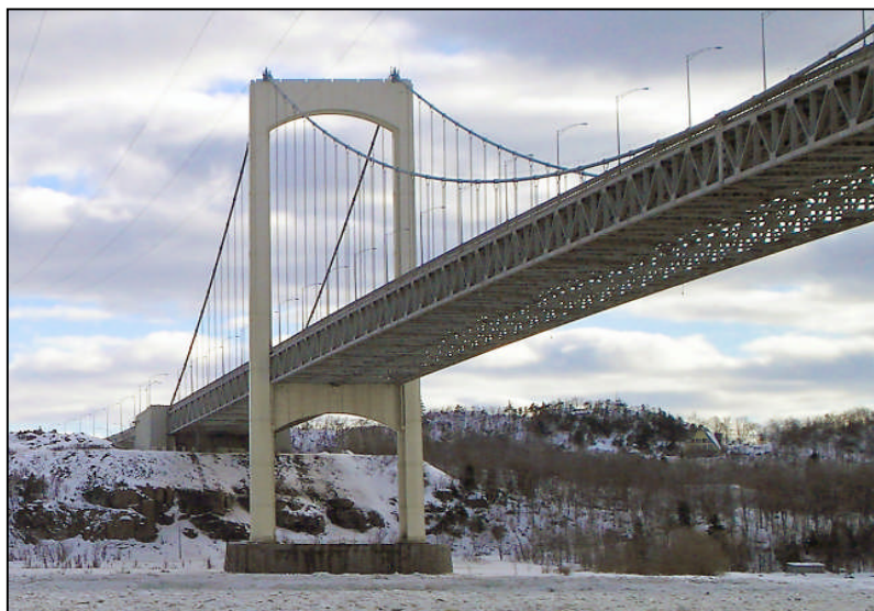
Figure 1-1 : Pont routier Pierre-Laporte, Québec city ; Longueur totale : 1041 m ; Portée principale: 668 m ; Hauteur totale: 116 m ; Année : 1966-1970
