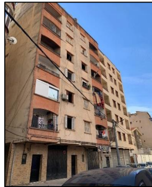
Figure 115: Des façades monotones source : auteurs
