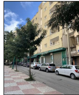
Figure 116 : Des façades monotones source : auteurs
