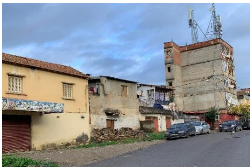
Figure 243 : vue en perspective avant intervention Source : auteurs
