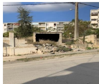
Figure 138 : déchets public Source : auteurs
