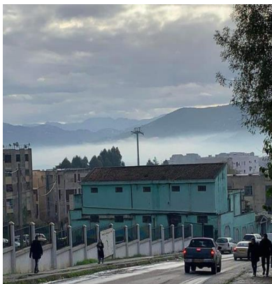
Figure 259 : vue avant démolition Source : auteurs
