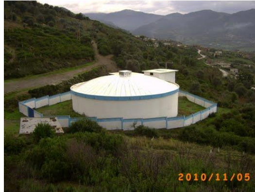
Figure 2: Réservoir pose au sol Château d'eau du village de Zouitna (périphérie de Jijel).
