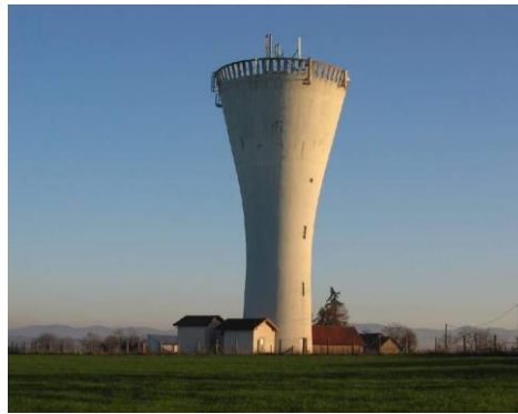
Figure 1: Réservoir surélevé de "Bel-Air" à Lapalisse (SIVOM Vallée de la Besbre).
