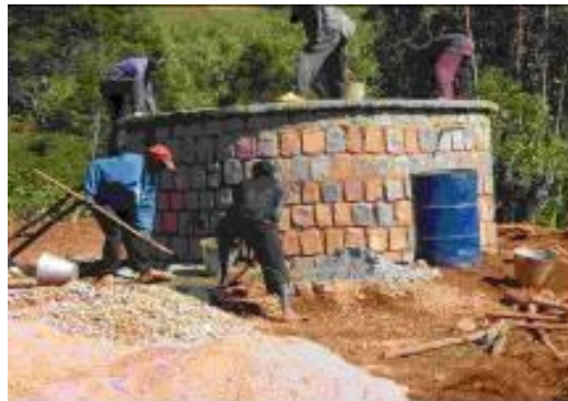
Figure 4: Réservoir en maçonnerie ( https://wikiwater.fr ).
