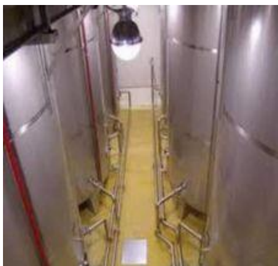
Figure 12 : Cuves de stockage de l'huile d'olive (Belkherroubi, 2018)
