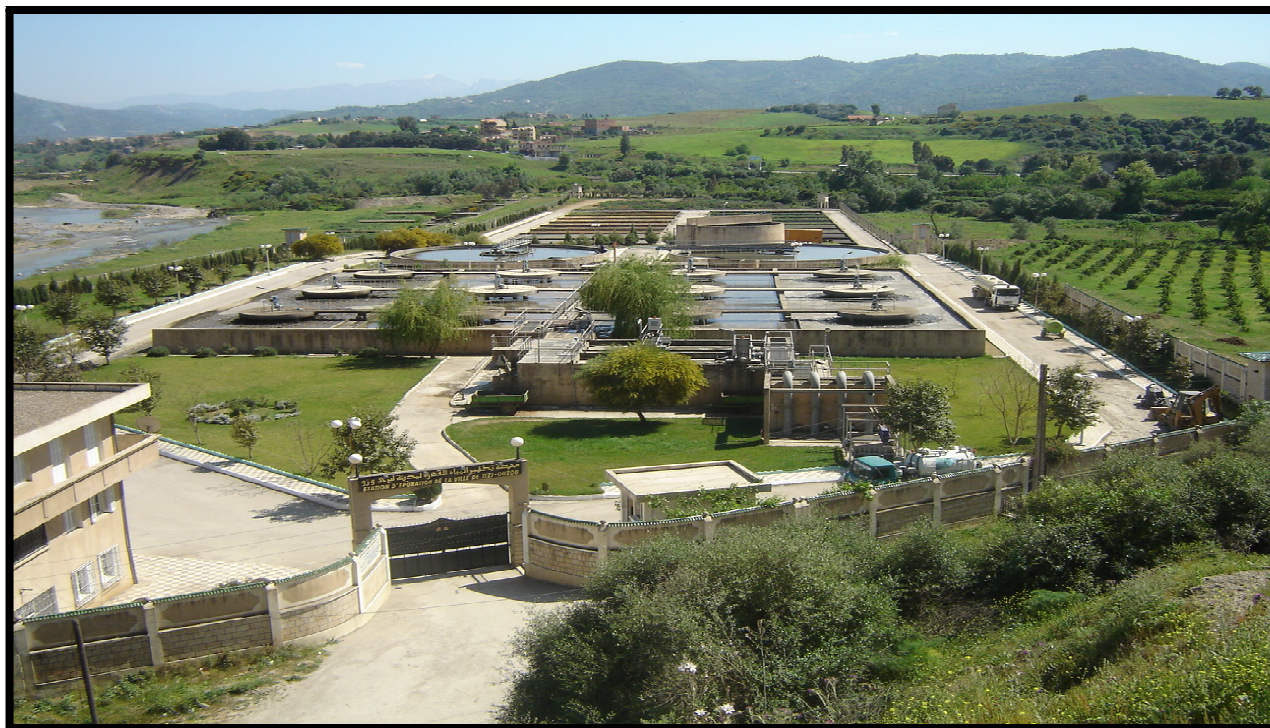
Figure 9: Vue générale de la STEP de Tizi-Ouzou.
