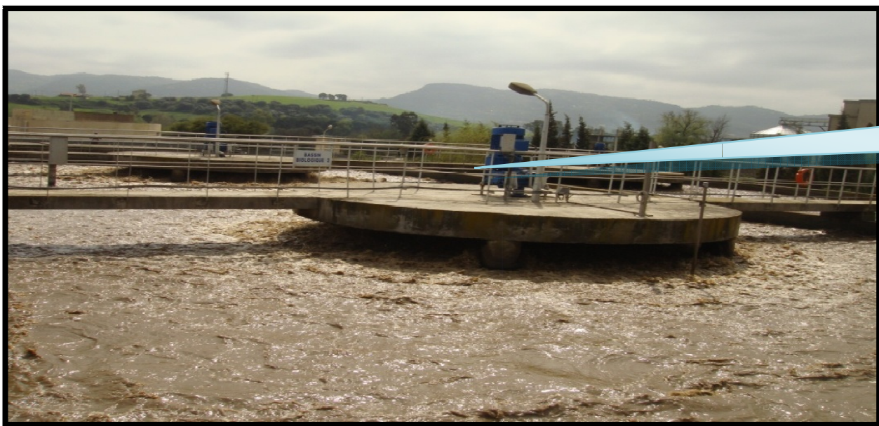
Figure 10 : Bassin biologique d'aération de la STEP (ONA, 2015).
