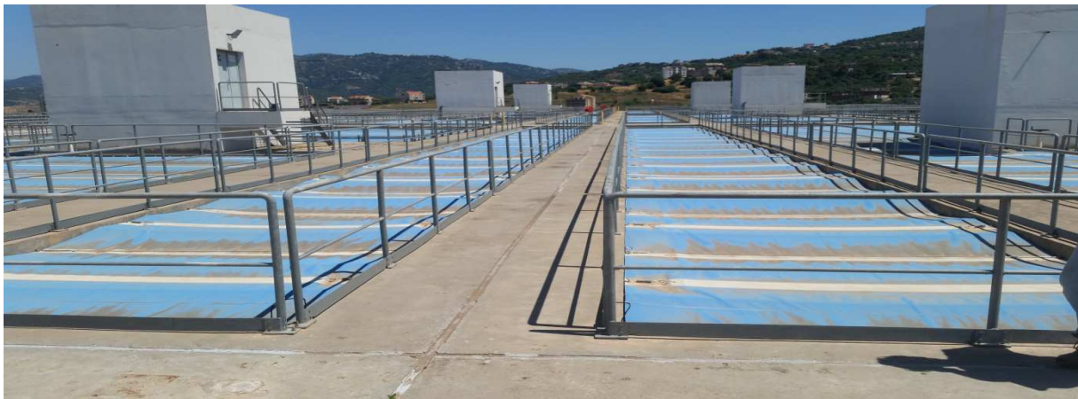
Figure I.8 : Décanteurs.
