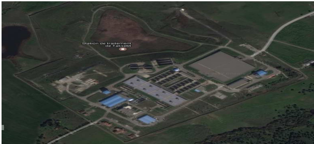
Figure I.5 : Station de traitement.
