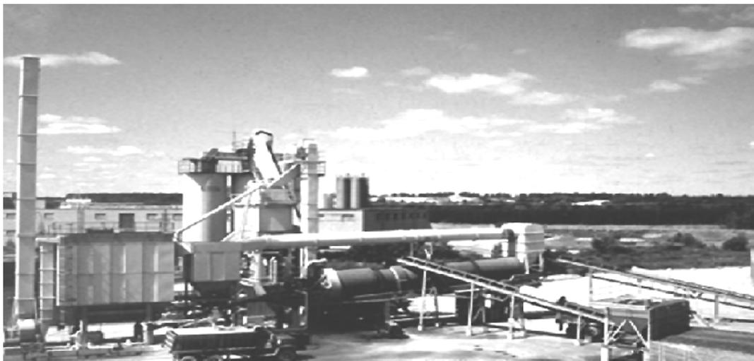
**Figure 3-2 : Poste d'enrobage type à fournée et à four tournant, à écoulement à contre-courant. .[39]**
