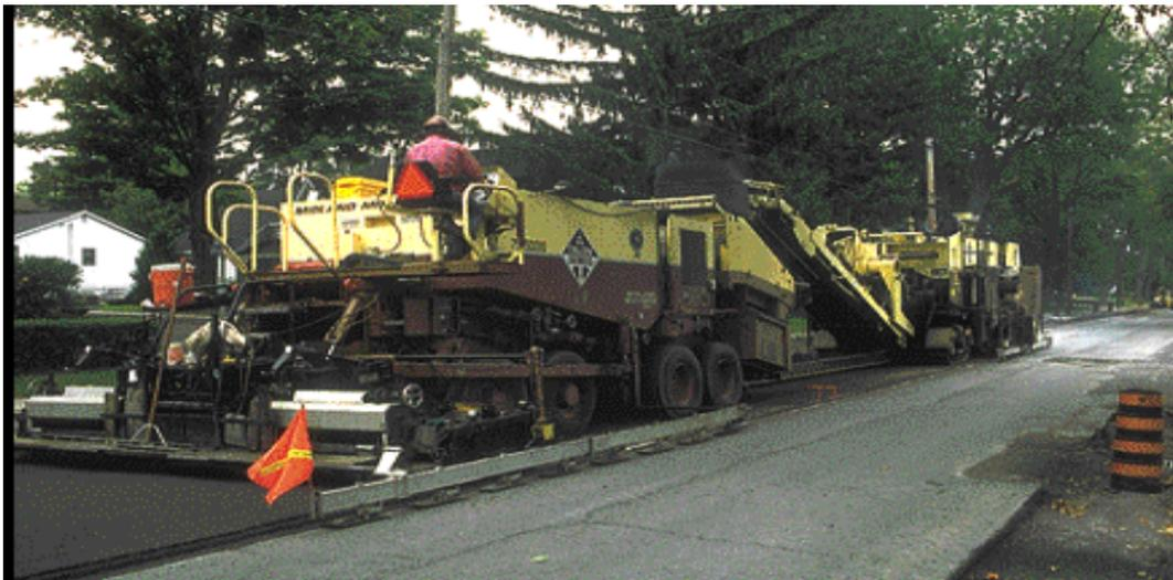
**Figure 3.6 Recyclage d'une rue à faible circulation[25]**
