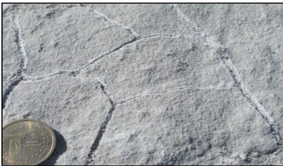
Figure I.6. Haloclastie (cristallisation de sel) d'une croûte calcaire en milieu évaporitique). www.geolsed.ulg.ac.be/processus/processus.htm#L'ALTERATION%20CHIMIQUE
