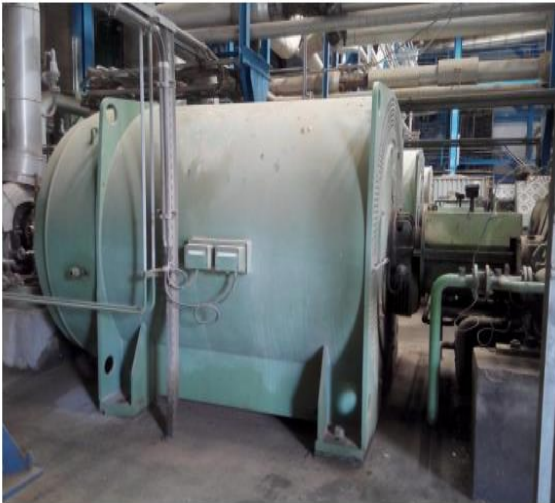
Figure 1.5 : Vue de face de la pompe d'alimentation.
