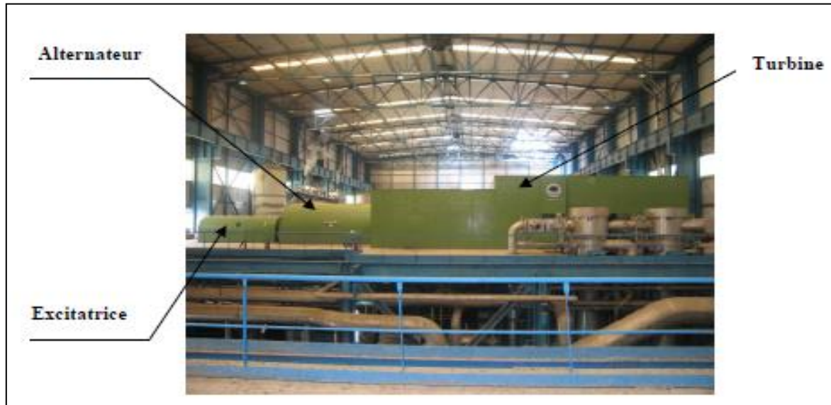
Figure I.6 : Vue réelle de la turbine à vapeur au niveau de la centrale.
