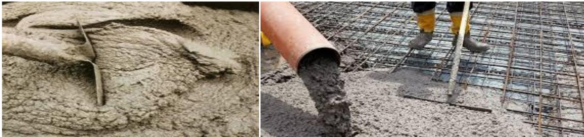
Figure (I.8) : le béton autoplaçant
