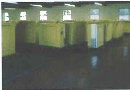
Fig44 : Local d'entreposage centralisé pour DASRI ]93[
