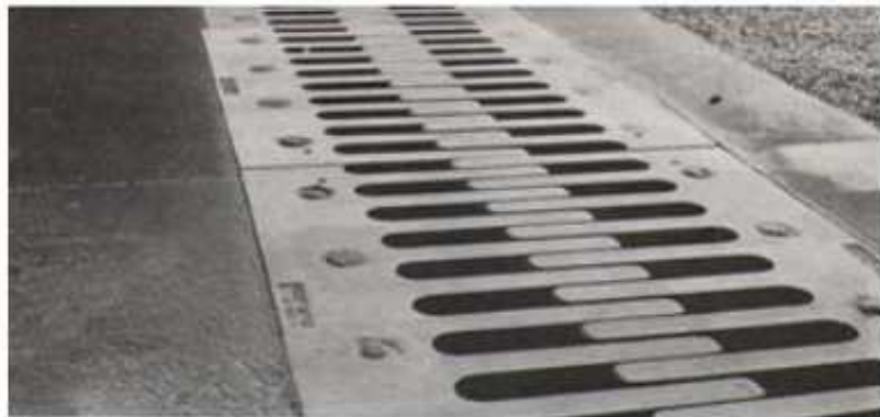
Figure IX.7 : Joint de chaussée
