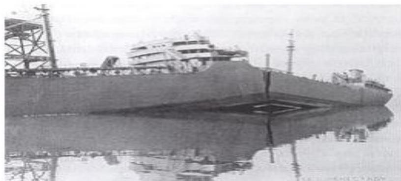
Figure I- 7 : Le S.S. Schenectady s'est séparé en deux par rupture fragile dans le port, 1943.
