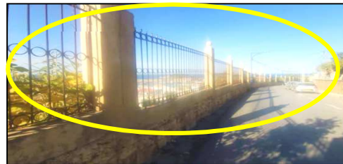
Figure 50 : la clôture de la rue 11 décembre Source : vue prise par l'auteur
