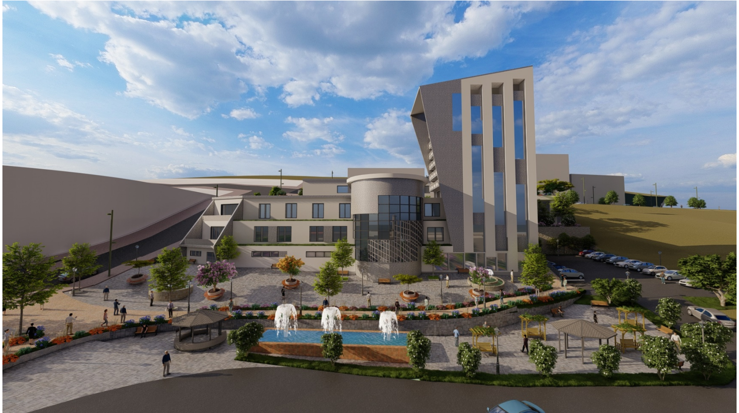
Vue sur la façade balnéaire
