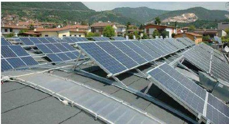
*Figure III.2 : Montage orientable*
