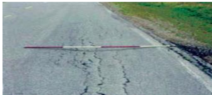
Figure I.26 : Les affaissements.
