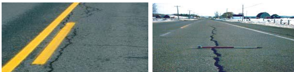
Figure I.28 : Fissures longitudinales.
