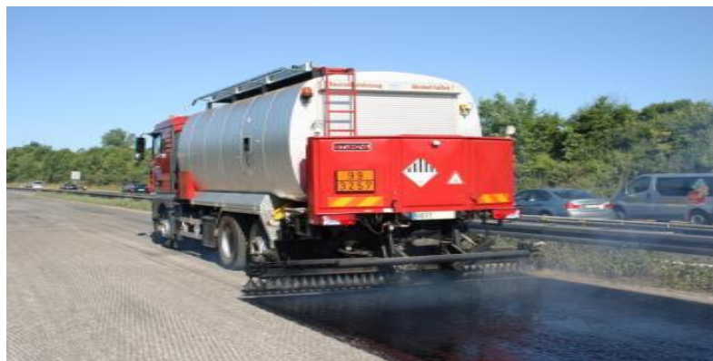
Figure I.22 : la mise en œuvre d'enduit superficiel
