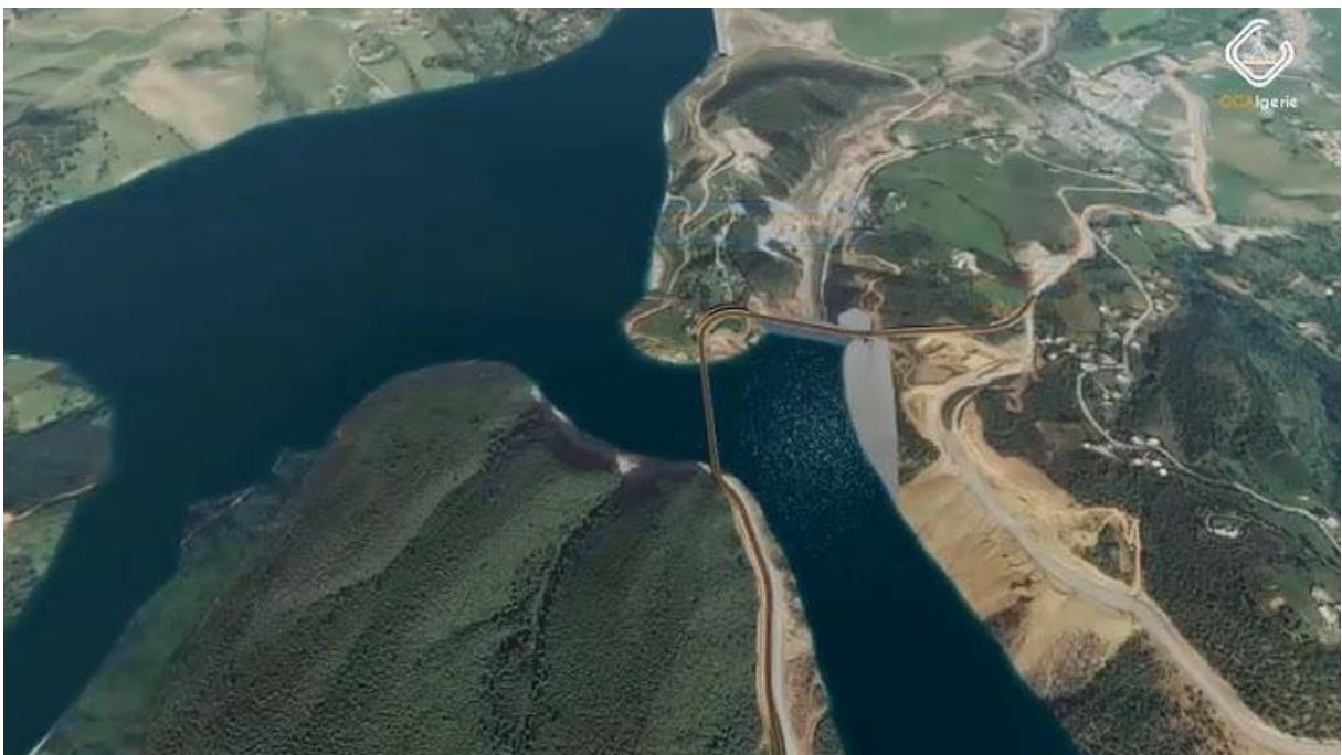
Figure 4 : Photos satellite du barrage de Taksebt (Google earth)
