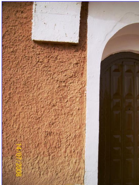
**Photo 6.3** : Utilisation de la texture rugueuse pour l'ombrage du mur.
