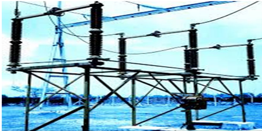
Figure III.11 : Sectionneur MT
