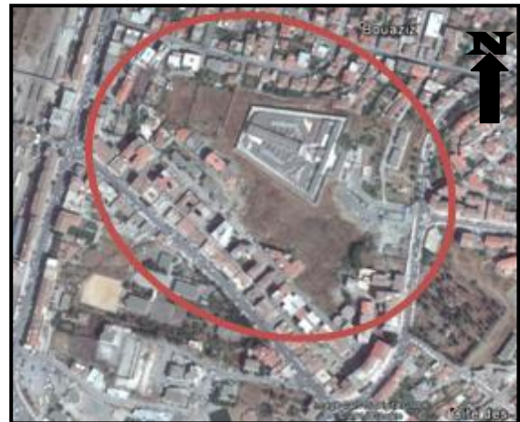
Fig.54 : Vue aérienne du site d'intervention
