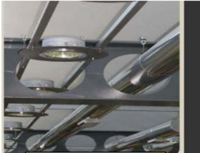
Fig : poutre alvéolaire
