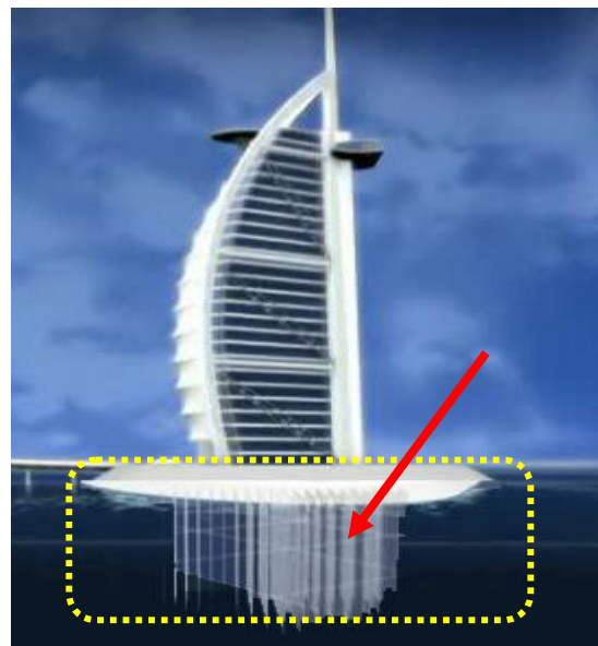
Figure82 : les fondations de l'hôtel,
