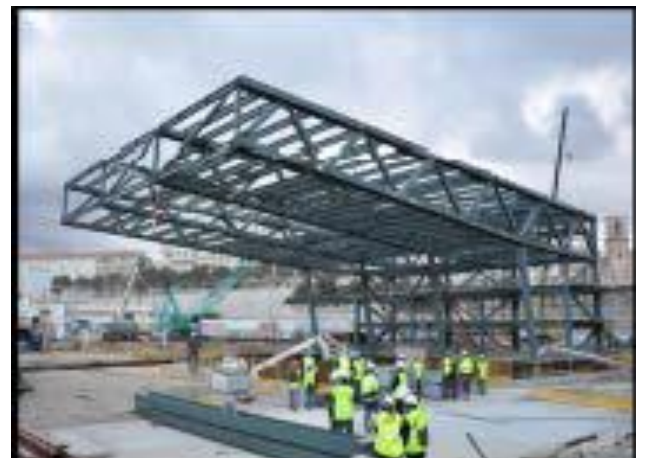
Figure131 : photos d'une Méga poutre Source : https://fr.wikipedia.org/wiki/Pont_en_treillis
