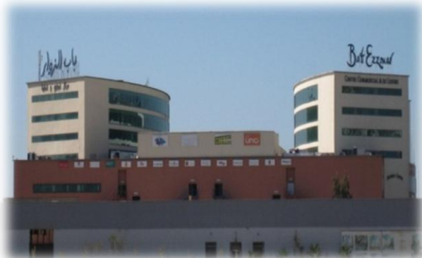
Figure34 : vue sur le Centre commercial Source : Photo prise par l'auteur.
