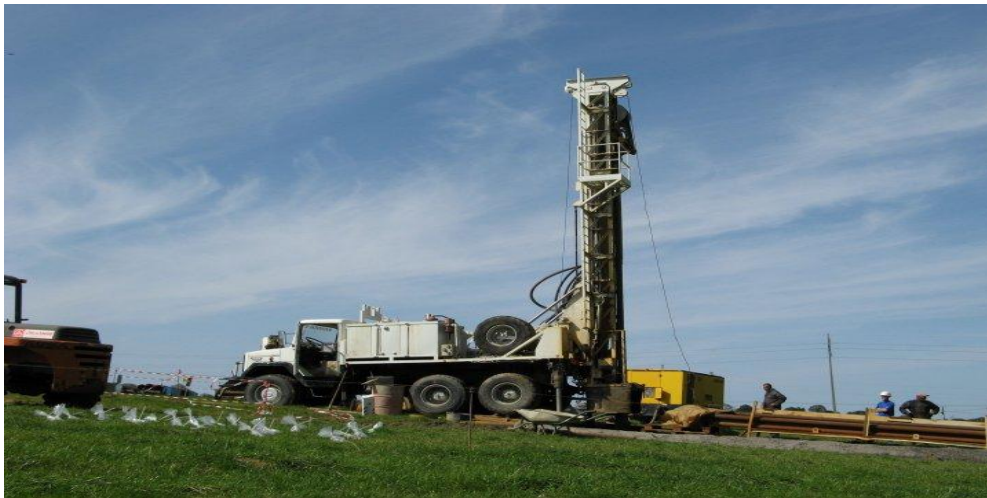
Figure 2: RAPSODI Forage F3 MFT. Forage au marteau fond de trou
