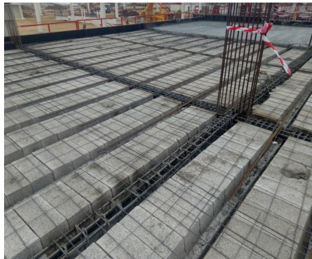
Figure III-2-1) : plancher à corps creux.
