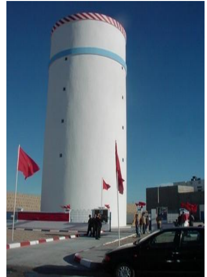
(b) Réservoir surélevé de 800 m 3 D'Elmarsa (Maroc)
