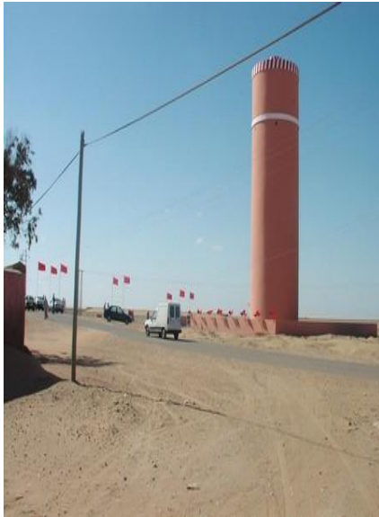
(a) Réservoir surélevé de 500 m 3 de Fom El Oued (Maroc)
