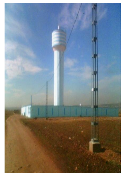
(f) réservoir surélevé de 300 m 3 à EL-Eulma (Algérie).
