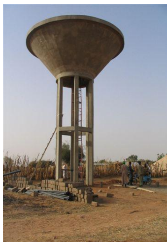
(a) réservoir surélevé de 30\text{ m}^3 au Mali.
