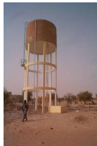
(b) réservoir surélevé de 60\text{ m}^3 de Foundou (Mauritanie).
