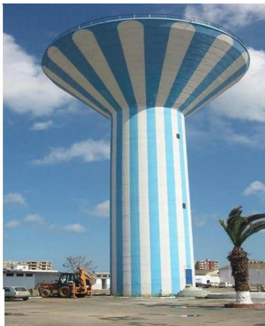
Figure 4.1 : Vue générale du réservoir sis à Berrahmoune
