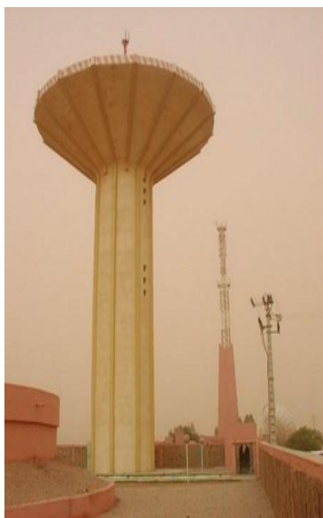
(a) Réservoir surélevé de 500 m 3 à Smara (Algérie).
