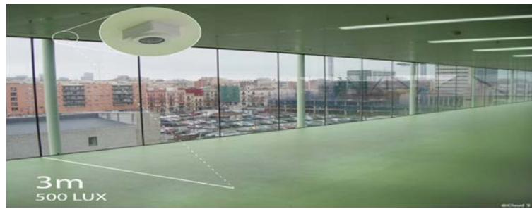
Figure 63: Les capteurs pour contrôler la lumière et la température Source : https://fr.wikiarquitectura.com/b%C3%A2timent/media-tic/
