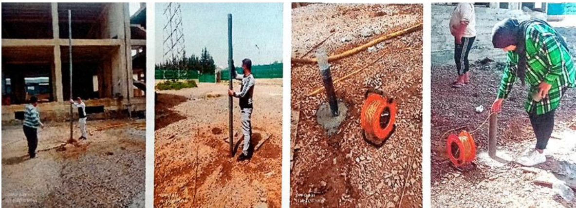
Figure 3-27 Disposition de piézomètre.
