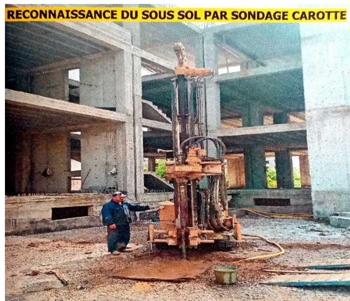
Figure 3-24 Reconnaissance du sous-sol par sondage carotté.
