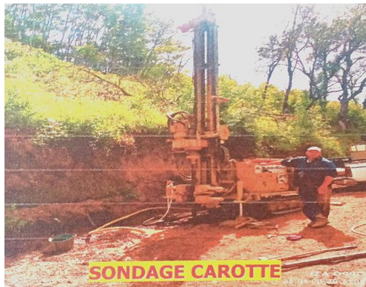
Figure 3-14 Sondage carotté.
