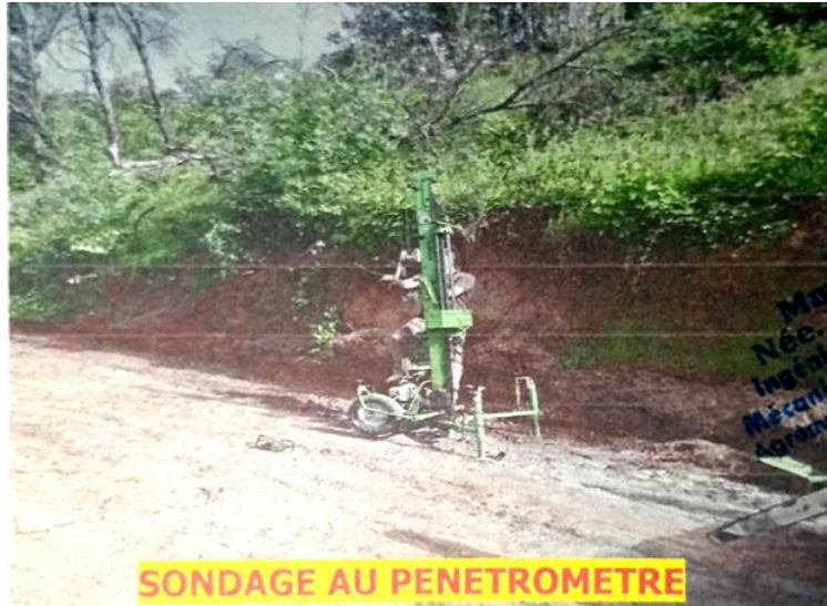
Figure 3-13 Sondage au pénétromètre dynamique lourd.
