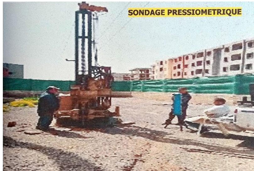
Figure 3-26 Mise en œuvre des sondages pressiométriques.
