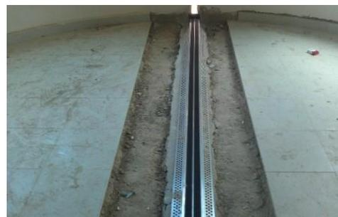
FIG74 : couvre joint a l'intérieur
