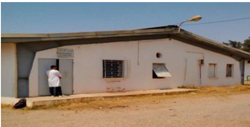
Figure 16 : photo du bâtiment cunicol vu de l'extérieur (photo personnelle)
