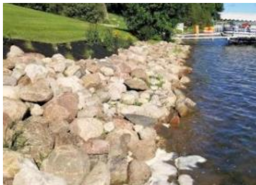
Figure (I.14) : L'enrochement.
