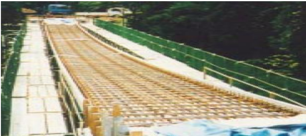
Figure I.23: Pont suspendu fabriqué en FRP [18].
