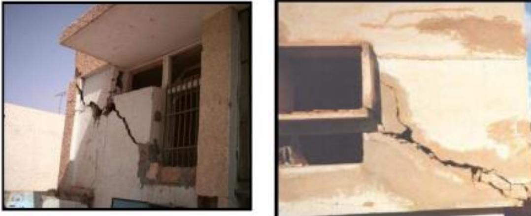
**Figure I.19.** Dégradations et fissurations des façades de bâtiment
