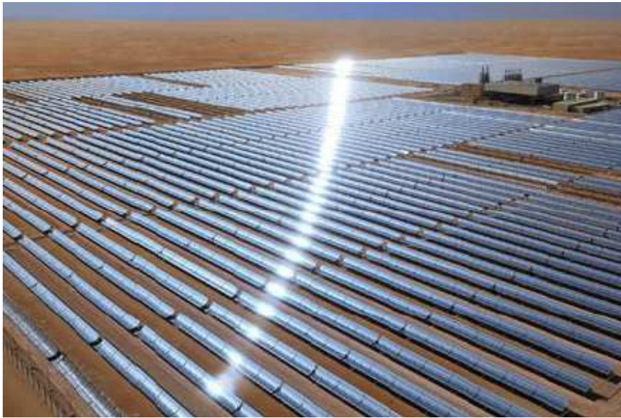
Figure III.8 : Vue aérienne des capteurs solaires de la centrale cylindro-parabolique de Shams, à Abu Dhabi. (Source : Shams Power group)
