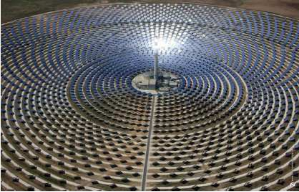
Figure II.3 : Vue de la centrale Andalous Gemasolar (source : Torresol Energy)
