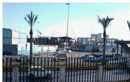
Figure I-63 : vue sur l'arsenal Source : auteurs
