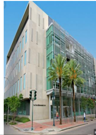
Figure III-8 :vue sur bio centre innovation NOBIC/Source : http://www.aiatopten.org/node/447
