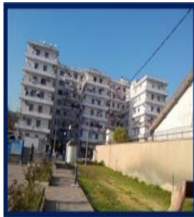
Figure III-7 : cité HLM Source : photos prise par l'auteur
