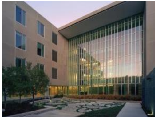
Figure III-16 : photo de cour paysagère/Source : http://www.aiatopen.org/node/447
