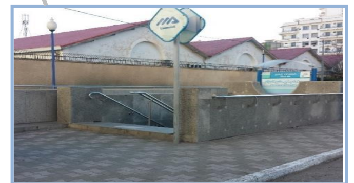
Des bouches de métro non repéré et non aménagé
