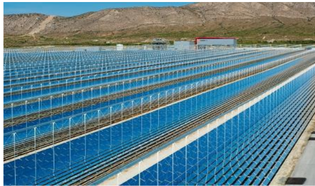
Figure 48: Vue de la centrale PE2 (source : Novatec Solar)
