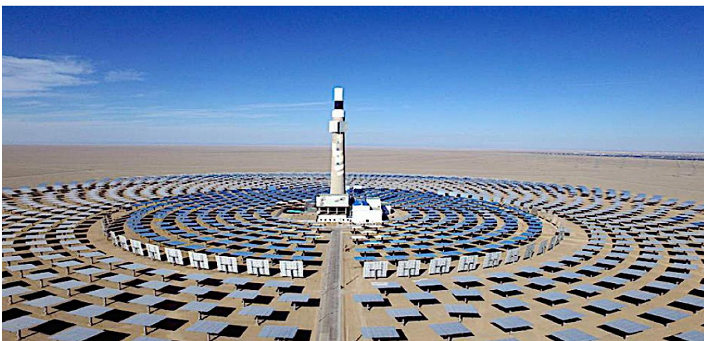
Figure 24: Centrale solaire à tour
