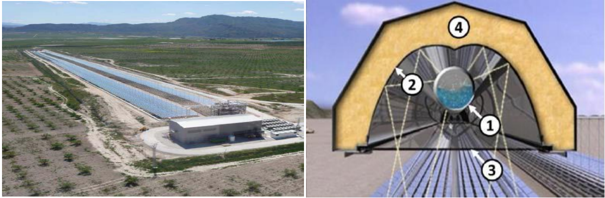
Figure 47: Centrale Puerto Errado 1 d'1,4 MWe utilisant des capteurs linéaires de Fresnel Nova-1 (source : Novatec Solar)
