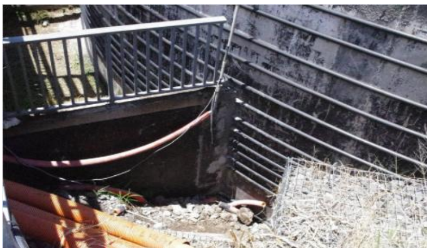
Figure 1.3 : Renforcement de l'ouvrage à l'aide de cerces de précontrainte.
