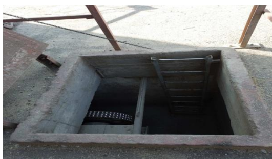
Figure 22 : Entrée des silos
