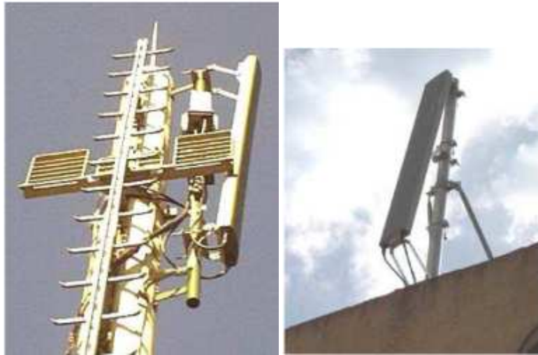
Figure.4 : Antenne directionnelle avec tilt négatif antenne directionnelle avec tilt positif
