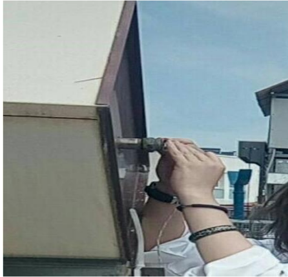
Figure IV.2: Emplacement de la sonde à l'entrée de la cuve.
