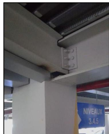
**Figure 120** : Assemblages : poteau béton armé - poutre métallique / Deux poutres métalliques
