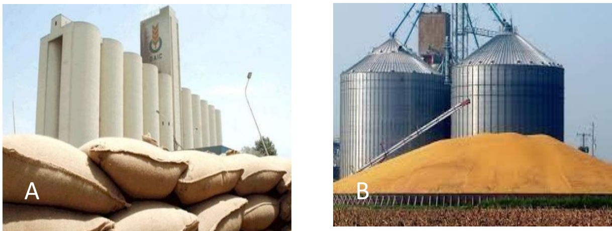
Figure 9. Stockage en silos : (A).Silos en béton (ANESRIF, 2024) ; (B).Silos métallique (CCLS Constantine, 2021)
